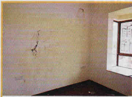
沈小姐客房牆壁霉跡顯而易見，惟發展商修補後仍未能解決問題。(于港民攝)
