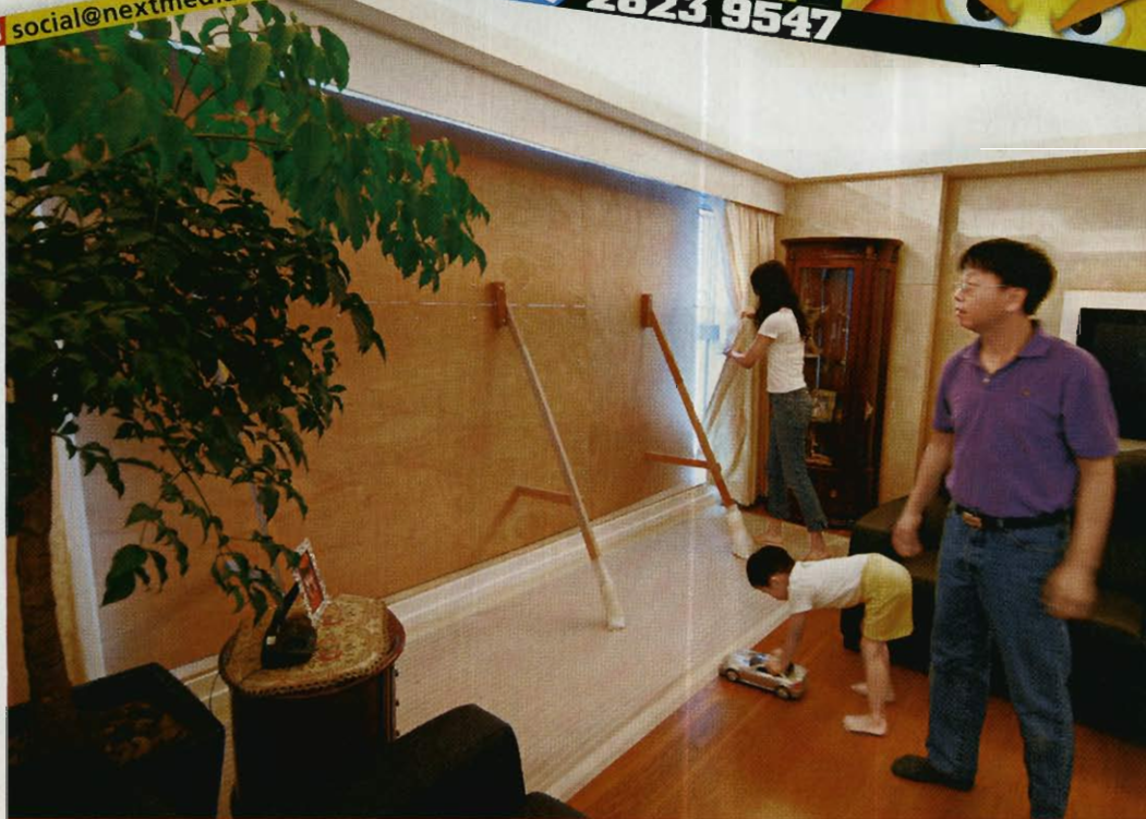
◀李太（白衣者）家中的巨型落地玻璃突然爆裂，須用木板封住。（嚴實攝）
